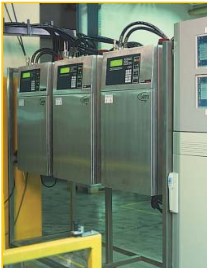
Eén compact en mobiel geheel op een RVS stief. Integratie van de 2 computers in een elektrische kast. Duidelijke naamgeving van de diverse componenten.
